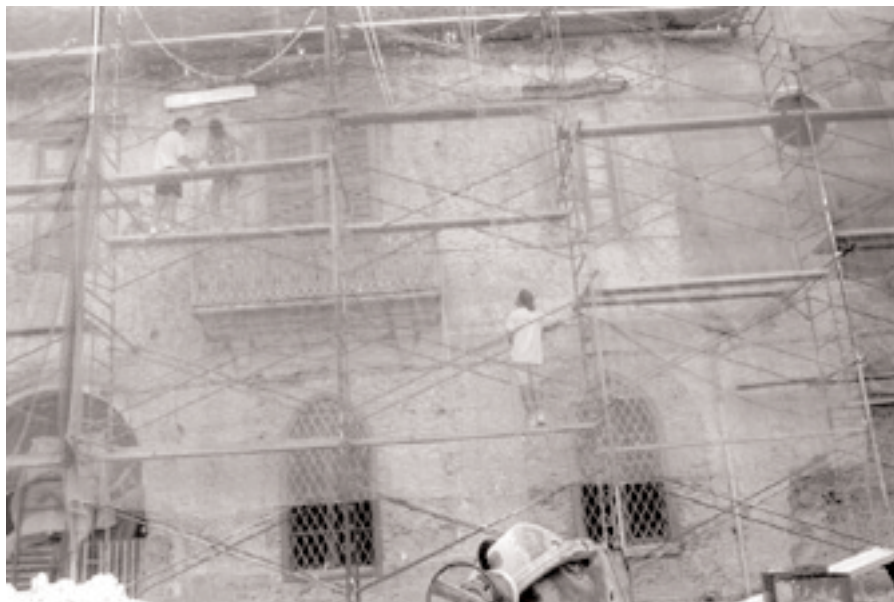
Trabajos de renovación del revestimiento del cuerpo principal del Colegio del Sagrado Corazón que permitieron identificarlo como la construcción original del Castillo de Godella. En la imagen, arqueólogos del Taller realizando un reconocimiento de los paramentos.
