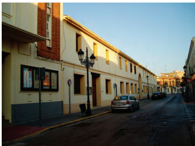
Porta d'entrada al saló dels jubilats a la façana principal de l'edifici, que dona al carrer Major (fotografia de l'autor).
