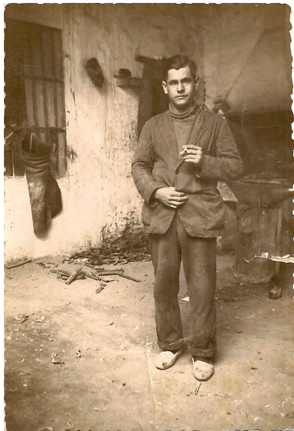
José Prades Frontera a la seua ferreria de la plaça del General Azcárraga (hui, de la Comunitat Valenciana). Fotografia presa en 1928, cedida per la família.
