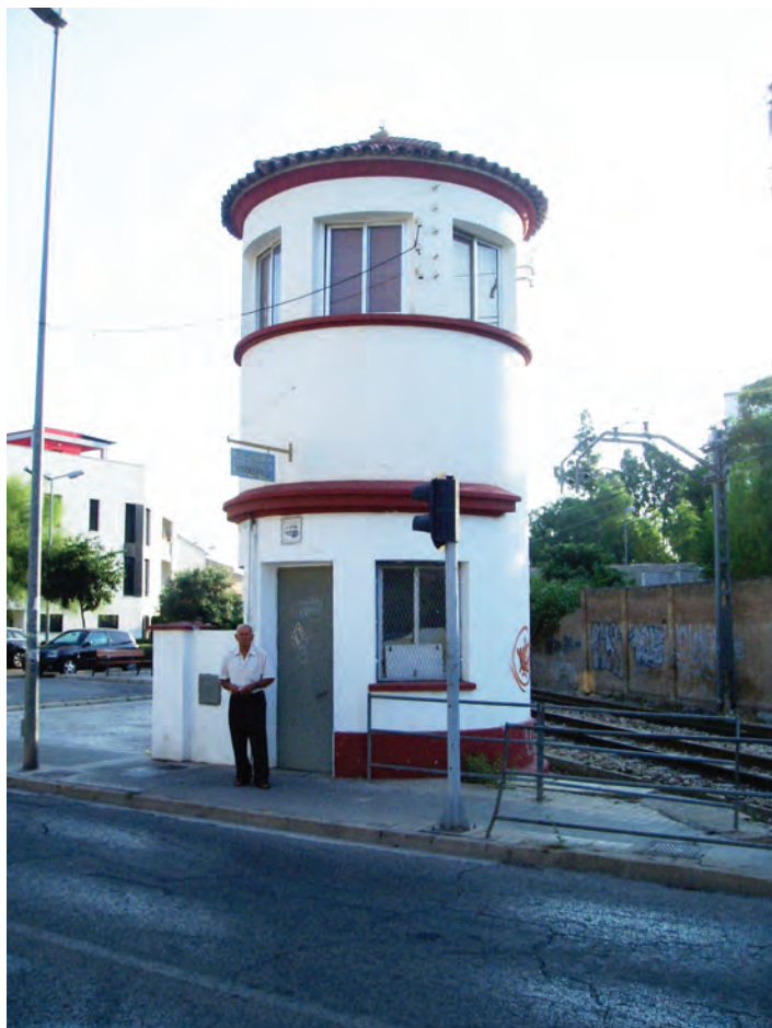
Torre de comandament de Godella a la carretera de Burjassot a Torres Torres (fotografia de l'autor).
