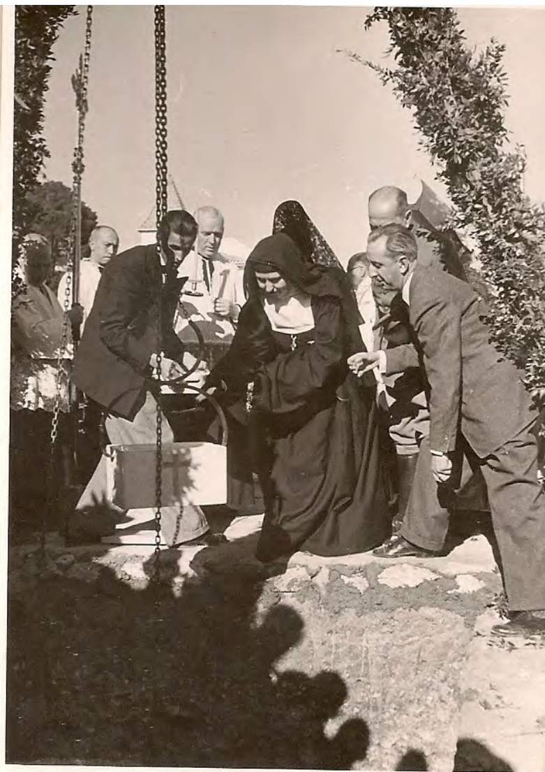
Col·locació de la primera pedra del monestir, 13.12.1941. En primer terme la primera superiora del monestir de Godella, mare Sor María Adela Emo. (fotografía AMV).
